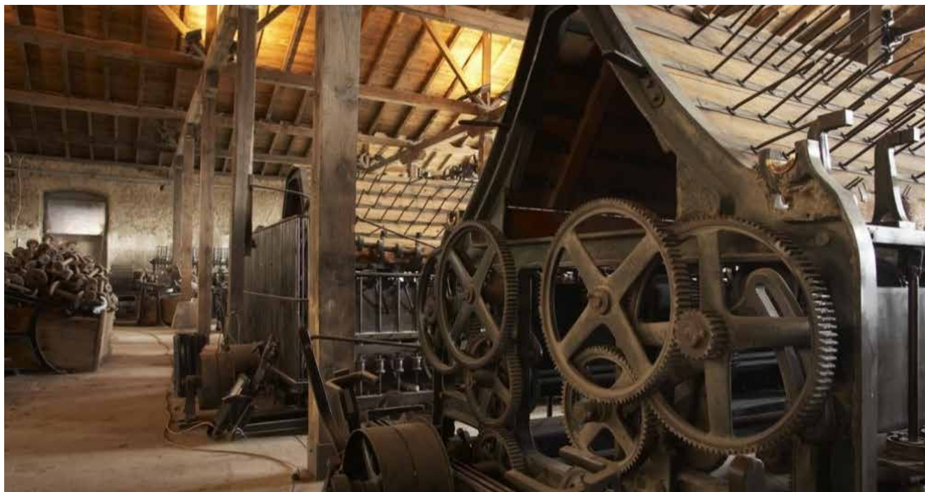
Εικόνα 2. Ο μηχανολογικός εξοπλισμός όπως σώζεται μέχρι σήμερα.
